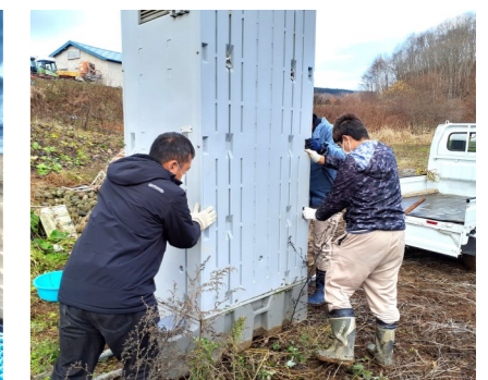
畑作業の終わりを告げる簡易トイレとトラクターの撤去作業。協力先の倉庫にしまいます。(11月12日撮影)
