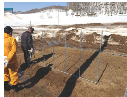
ハウスの骨組みを建てる
