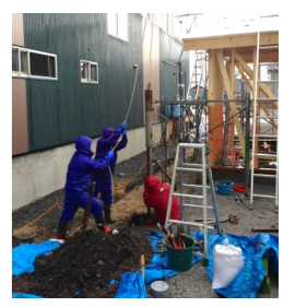
管を地下水層まで打ち込むところ
